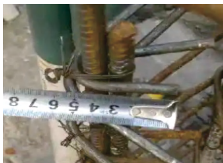
箍筋弯钩长度、弯折角度不规范
