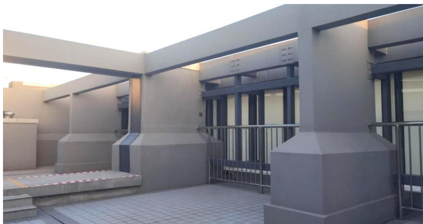
出屋面构建被动区延伸节点图
