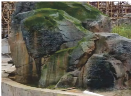
塑石假山山体面层裂缝、脱落
