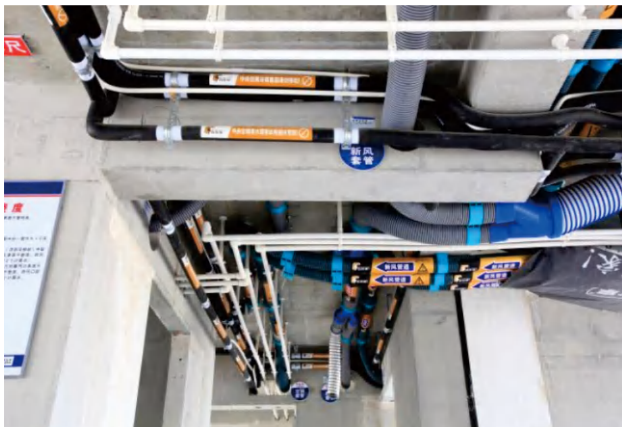
多联机系统安装工序样板图
