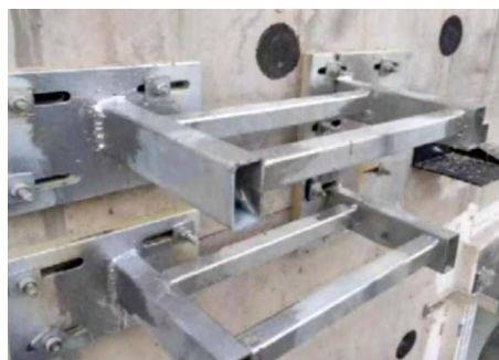
埋板断热桥处理完成效果
