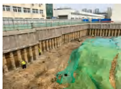
支护结构变形
