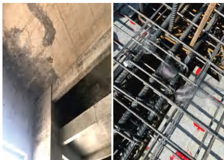
梁柱核心区混浇
