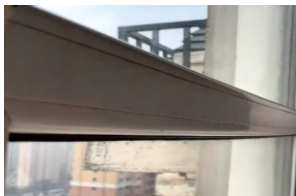
窗框型材弯曲变形 入户门关闭不严
