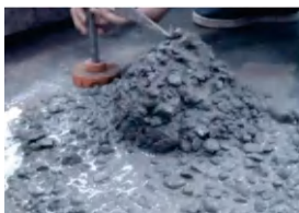
混凝土泌水、离析，施工时私自加水
