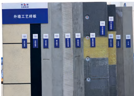
外墙保温样板工序图
