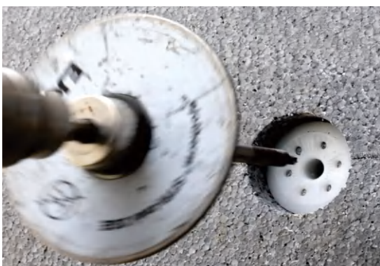
断热桥锚栓沉入式打法
