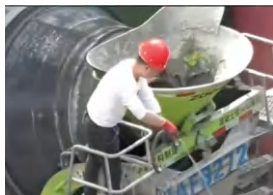
混凝土泌水、离析，施工时私自加水
