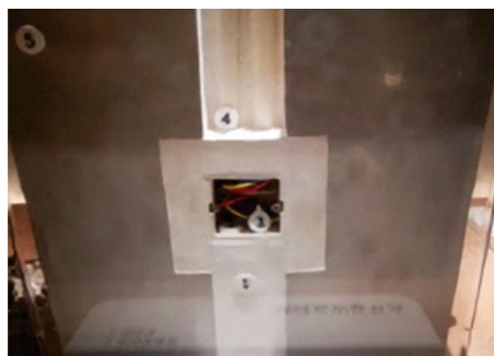
线盒封堵工序样板图
