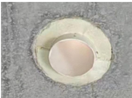
管道聚氨酯发泡保温封堵
