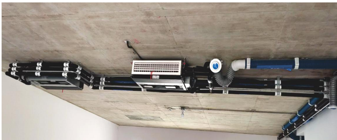
新风空调管路安装
