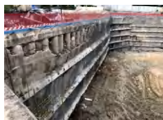
支护结构变形
