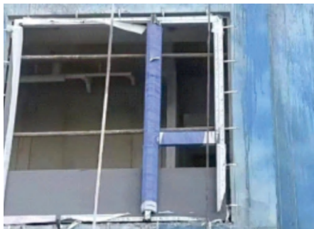
外窗固定片单边固定
