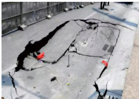
基坑周边地面沉降
