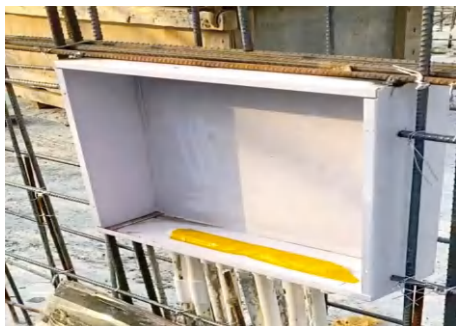
洞口加筋不到位、遗漏或尺寸规格错误
