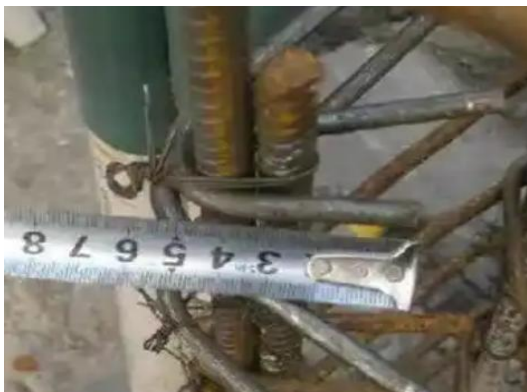
箍筋弯钩长度、弯折角度不规范
