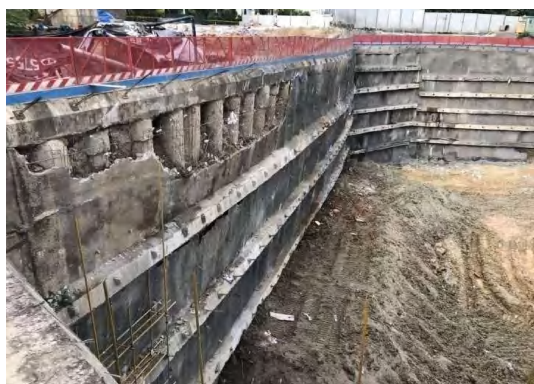
支护结构变形
