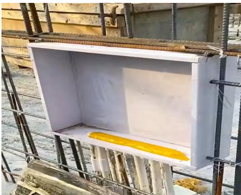
洞口加筋不到位、遗漏或尺寸规格 错误
