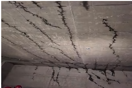
混凝土裂缝
