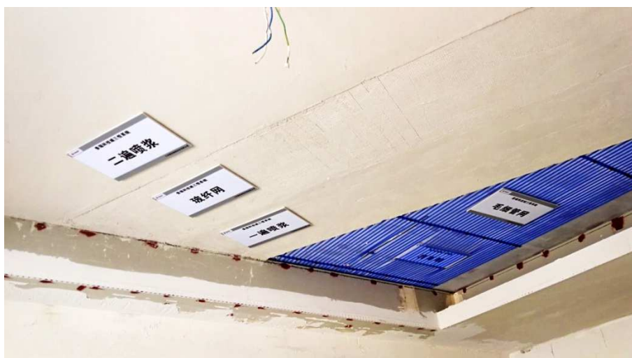
图 6.9.3: 石膏板基层毛细管辐射湿式安装工序图
